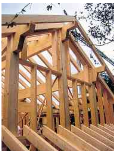
Für das Wiggertaler Familien-KMU ist keine Holzkonstruktion zu schwierig.
