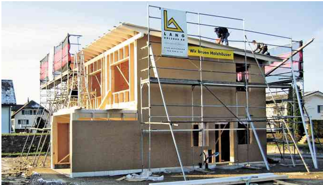
Aus Holz – und ganz schön modern: Im Fassadenbau arbeiten die Holzbauspezialisten mit Massivholz-Schalungen, verschiedenen Plattenmaterialien, Metallpaneelen oder Sandwichelementen.
